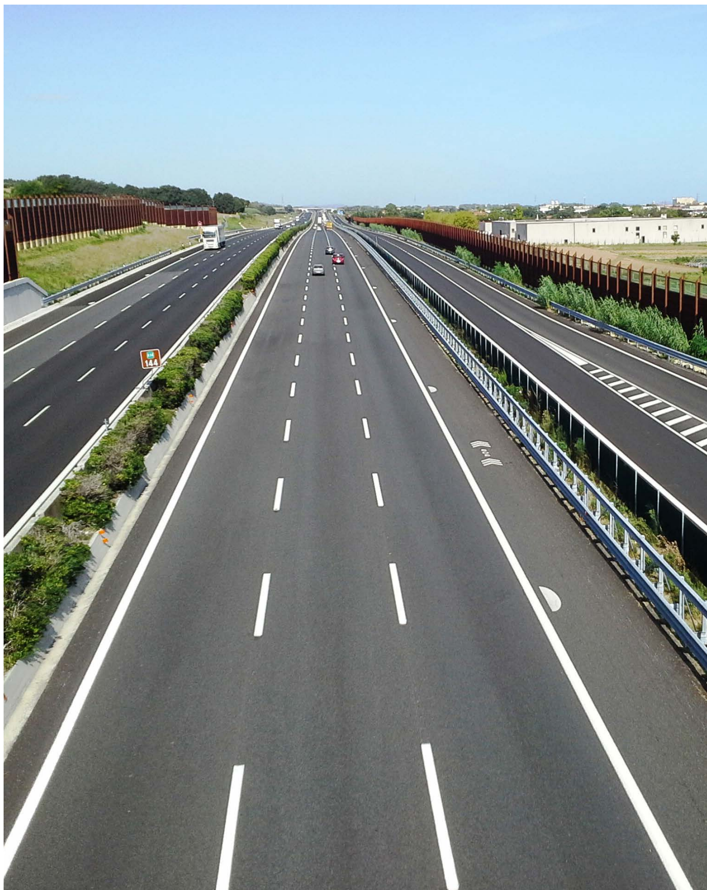
Autostrada A14 — Ampliamento carreggiata Sud-Nord e Complanare Senigallia
