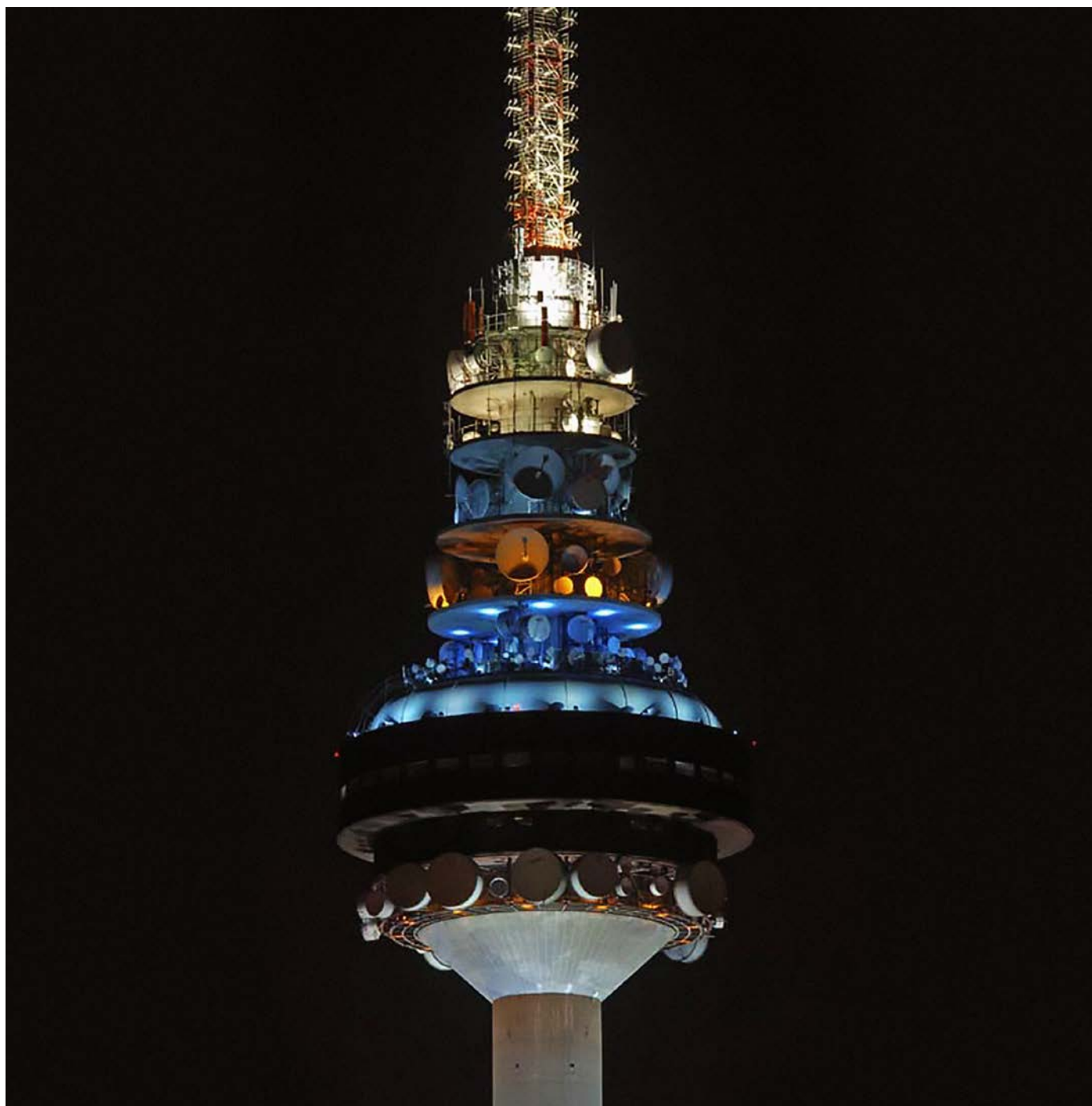
Torre España — Cellnex Telecom
